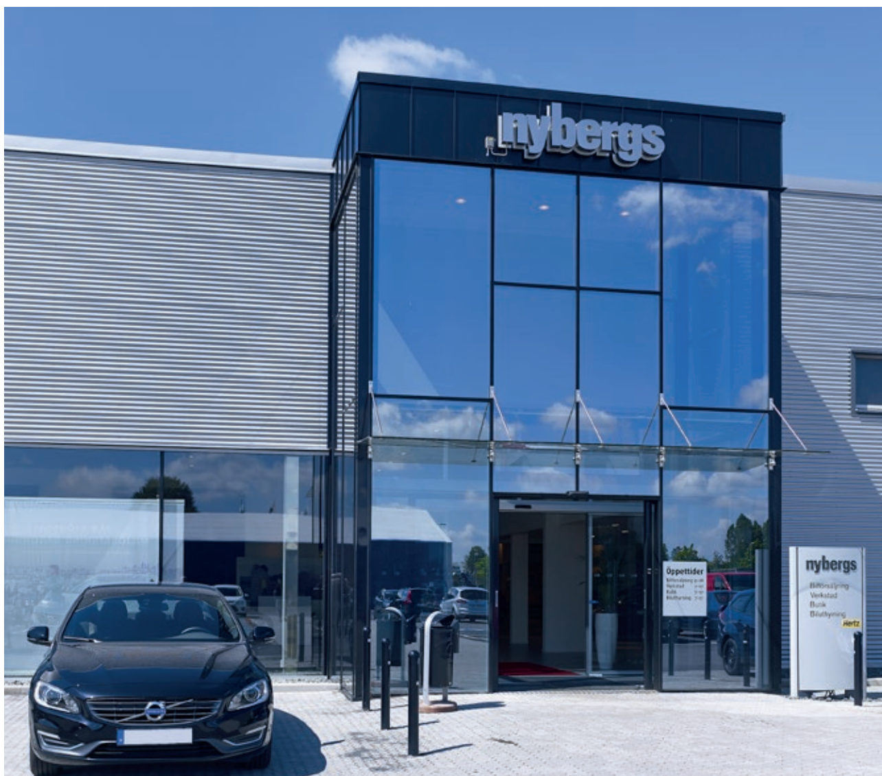
Optima 42844 med dæklister 42863 giver en smal udvendig profilbredde
